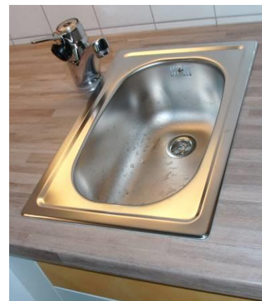
HANDWASCHBECKEN VORHANDENER NIEDERDRUCK-MISCHER ENTKALKT BEKAM NEUE DICHTUNGEN
